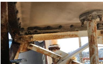
【排水管交換・架台塗装前】
