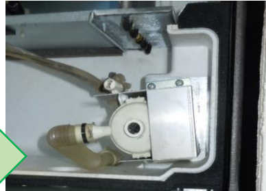
【ドレンポンプ清掃後】
