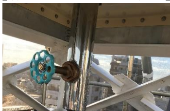
【排水管交換・架台塗装後】
