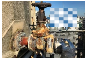
【給水配管・バルブ交換前】
