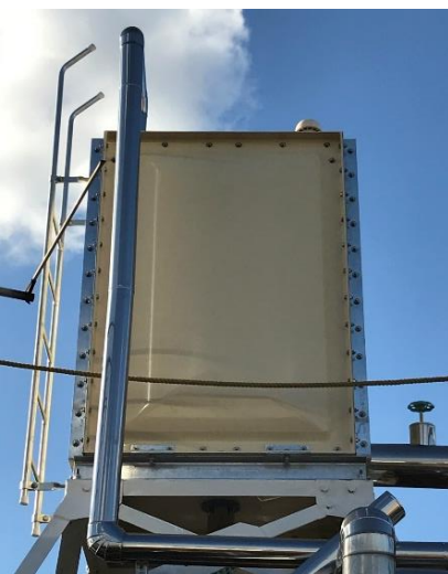
【高架水槽本体交換後】
