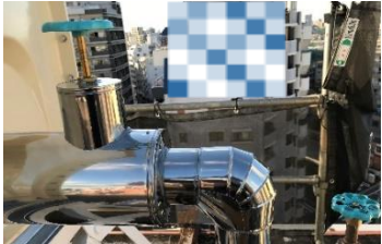
【給水配管・バルブ交換後】
