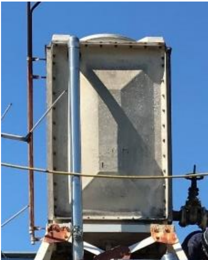
【高架水槽本体交換前】
